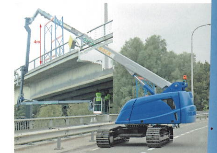
UNTER BRÜCKE 13M NEG.
