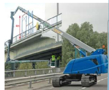
Inspection sous pont 13m neg
